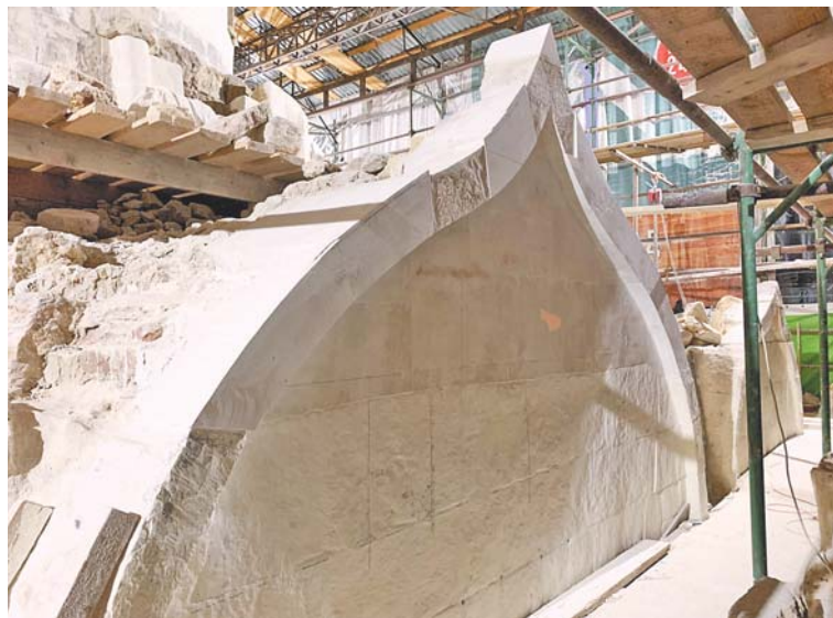
▲ Восстановленный тимпан центральной закомары. На подлинные нижние ряды кладки установлены четыре современных ряда белого камня, в которые вставлены два найденных подлинные камня
