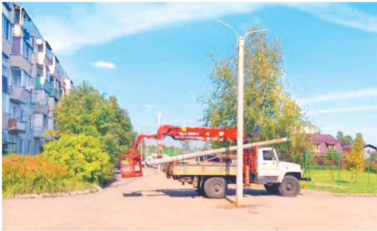
ОСВЕЩЕНИЕ РЕГИОНАЛЬНЫХ ДОРОГ
