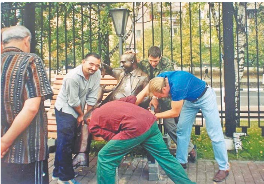
Фото сделано во время монтажных работ
