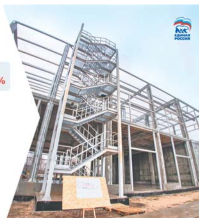
Очистные сооружения в п. Горки-10
