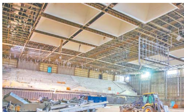
Капитальный ремонт Академии дзюдо завершится к концу года
